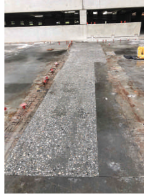
Fig. 6: En la mayoría de las áreas se requirieron numerosas pasadas del escarificador para eliminar el concreto dañado.
