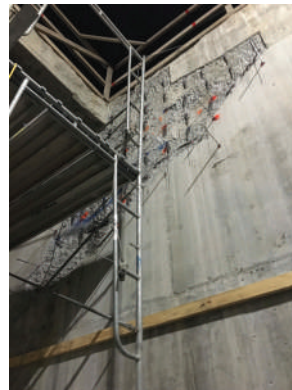
Fig. 7: Reparación de parcheo vertical.
